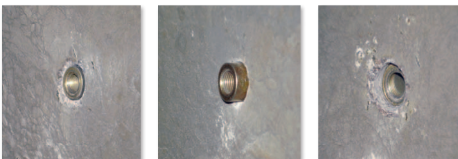
En pravilno in dva nepravilno zabita svetrovca
