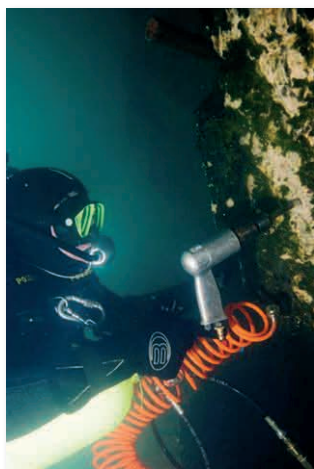
Dare med izdelavo podvodnega sidrišča
